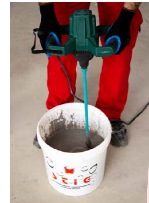
Miješanje dvije komponente vodonepropusnog premaza za hidroizolaciju STIGOELAST
